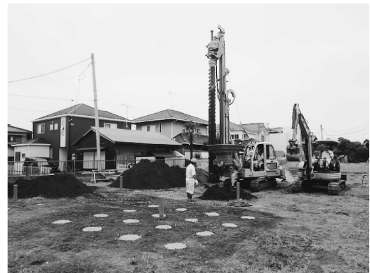
写真-1 エコジオ工法による施工状況
