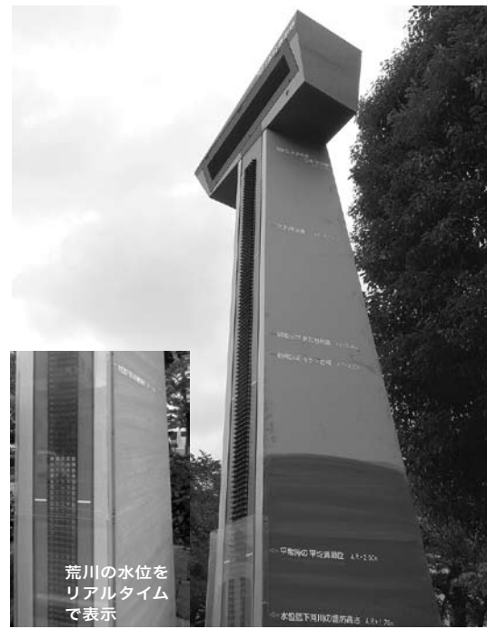
東京・江東区役所前の荒川水位表示塔（左）と東京・墨田区の高標表示板（上） 江東区役所周辺は、周囲の河川の水面より土地が低くなっているゼロメートル地帯。周辺河川の荒川の水位をリアルタイムで電光表示している。塔の頂部には河川に関する情報を流す。また、側面は、平常時や過去の大洪水を標示した「水準標」となっている。 高標表示板は日常的に防災意識を向上させる方法として、電柱や公共施設、さらに道路標識などへの設置も始まっており、沿岸地域を中心に全国的に広がっている。
